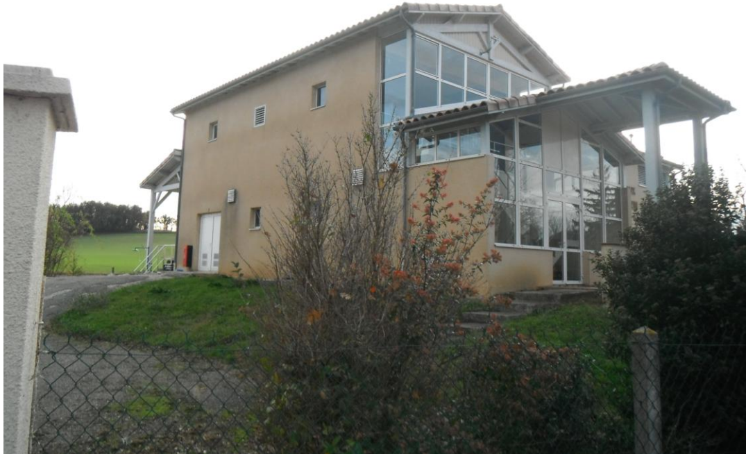
La station de traitement
