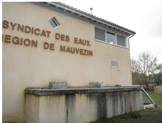
Compartiment de l'inter-ozonation avec accès à droite
