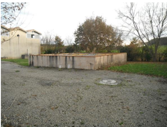
Ancienne bache de stockage
