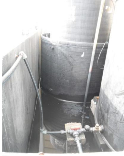
Stockage de réactifs sur bac de rétention
